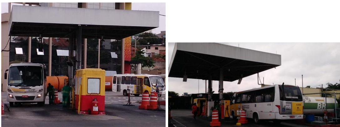
Figura 07: Vista da área de abastecimento
